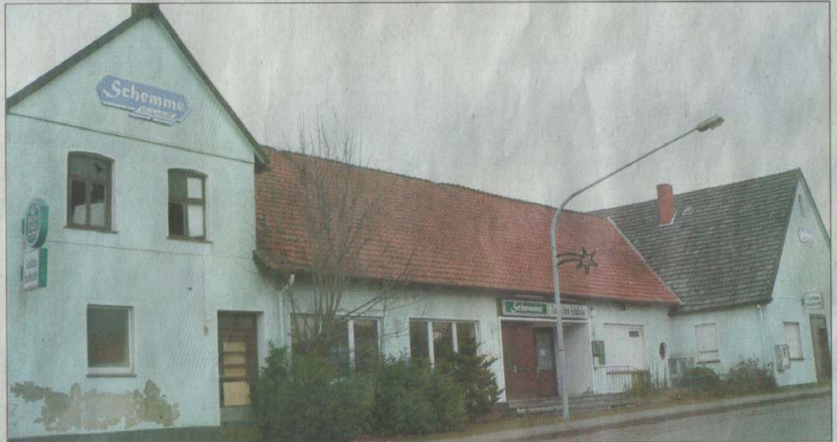
Das Gelände der ehemaligen Gaststätte Schemme an der Ortsdurchfahrt Haldem. Die Raiffeisen-Genossenschaft Damme will das Gebäude
